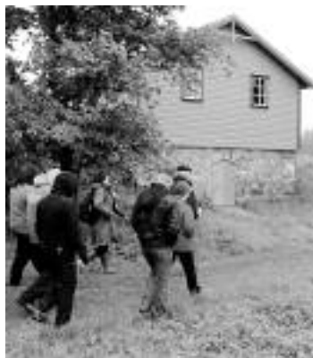
NYBYGG: Kjellerbua var ferdig i juni i år, og dermed er steinkjelleren under sikret mot forfall.
